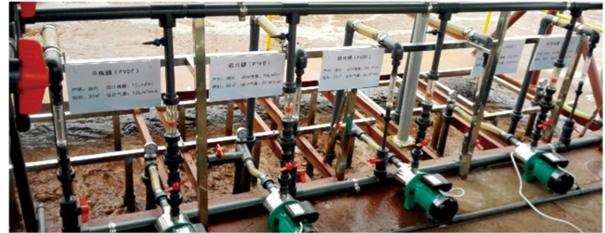
浙江大港印染厂生化好氧池
